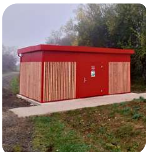
Local sécurisé pour vélos
