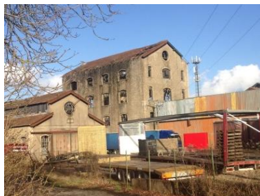
Carreau de la Mine Trieux
