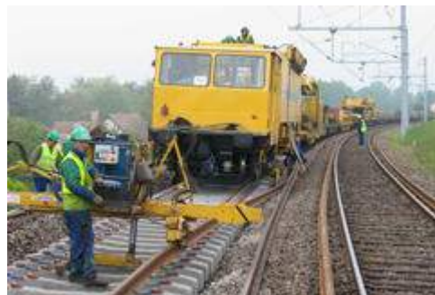
Longs Rails soudés sur traverses béton
