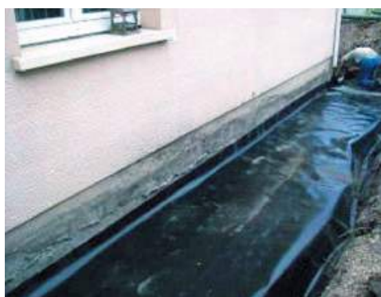
Figure 22 Géomembrane en cours de pose (Source Socabat)
